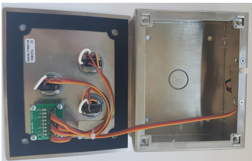
Abbildung 3: Sabotagekontakt eingebaut und angeschlossen
